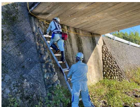
近接目視による点検状況
