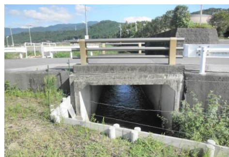
溝橋（葉生池橋）
