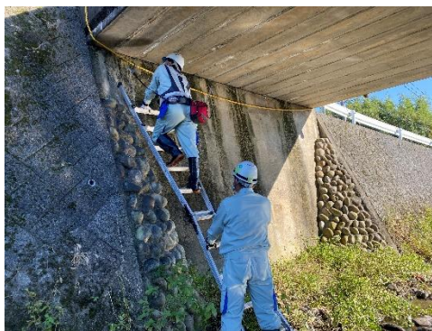
近接目視による点検状況
