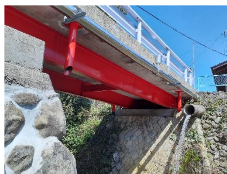
鋼 H 桁橋（上之橋）
