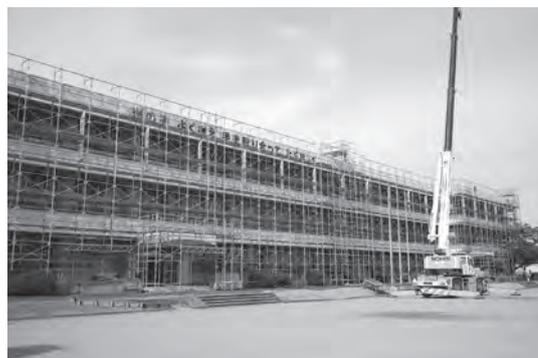
東小学校は昭和58年に建築され41年が経過しました。これからも児童が安全・安心に学校生活が送れるように、令和6年度・7年度の2カ年にわたり、外壁改修・窓ガラスの交換・照明器具のLED化・給排水管の改修など、長寿命化改修工事を行っています。
