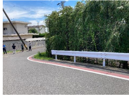
⑦ 歩行者、車の双方から見通しが悪い。道が狭いため、生徒が通る際に車が通ると危険である。カーブミラーが設置されている。それをよく見て通る必要がある。
