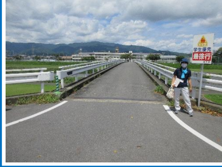
⑥ 生徒が通る際に、車が通ると狭くて危険である。
