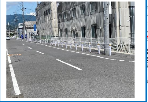
⑧ 工場地帯で大型車がよく通る。工場から出入りする車に注意が必要である。
