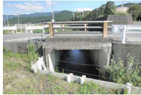
溝橋（葉生池橋）
