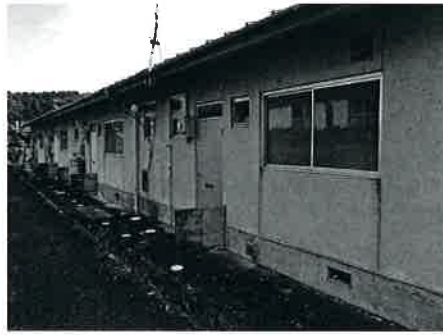
▲空き家となっている梅谷町営住宅
