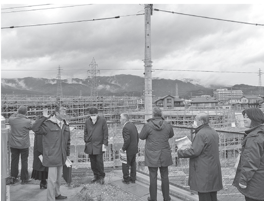
▲垂井こども園建築工事現場の視察
