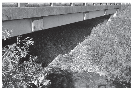
土砂が堆積し河床が高くなっている場所
