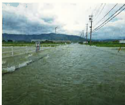
H25.9.18 台風18号 県道栗原青野線 冠水
