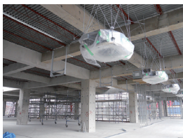
空調機器の取付
