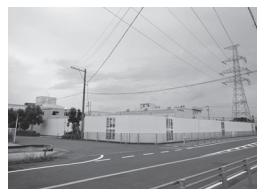
建設現場の状況(6月18日現在)
