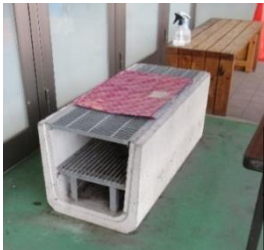
かまど型ベンチ (普段は、写真上のように木製のベンチ台が置かれていて、災害時には、台を取り外してかまどとして利用します。)
