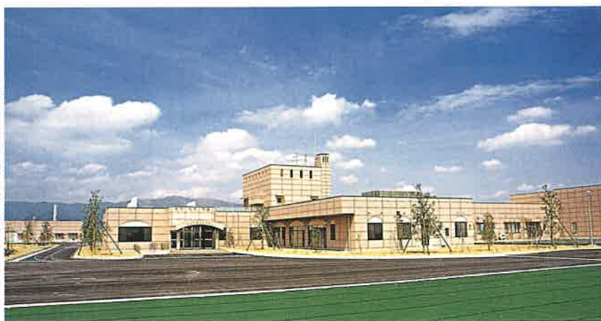
垂井町浄化センター 管理棟
