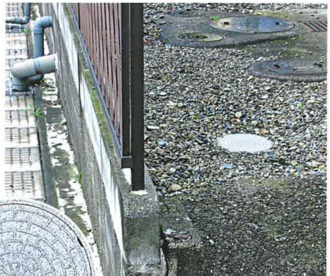
(公共汚水ます設置状況)
