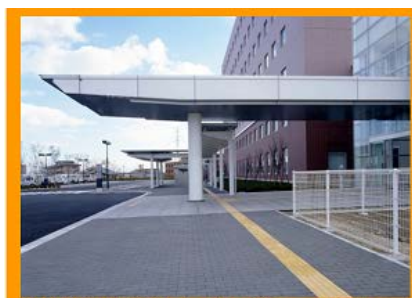
段差がなく、見通しのよいアプローチ通路 視覚障害者誘導用ブロックの敷設
