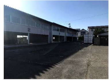
No3,4,5. 倉庫 2・3・4
