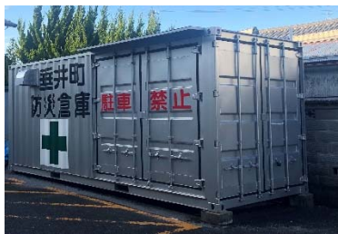
No9. 防災倉庫
