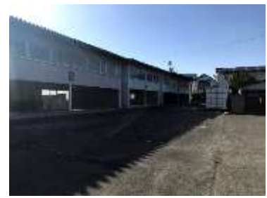
No3,4,5. 倉庫 2・3・4
