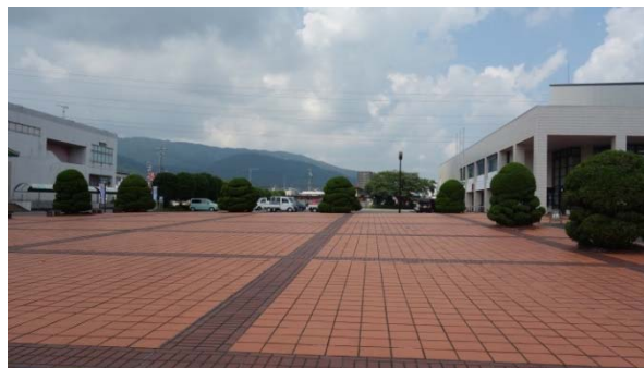
図：既存文化会館外観と広場
