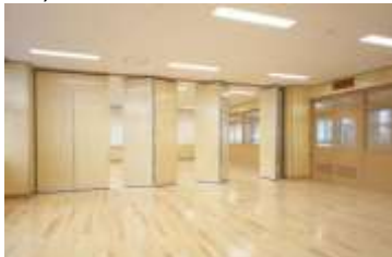
多目的スペース(稼働間仕切り)のイメージ (御幸中学校) 出典：小松ウォール
