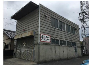
No8. 消防団車庫・倉庫兼 土地改良区事務所
