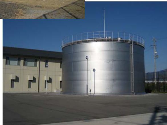
《左上：相川右岸低区配水池 右下：第2水源地浄水池》
