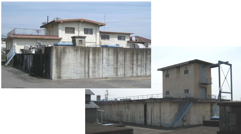
【第 1 水源地 配水池の様子】
