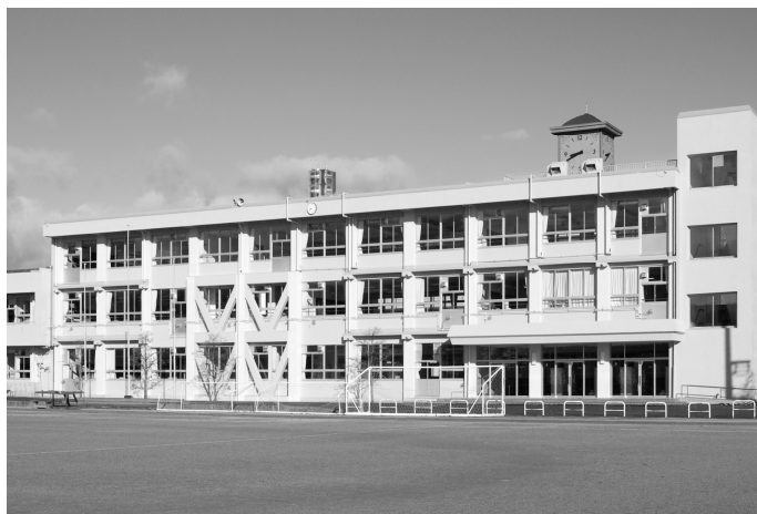
耐震工事を行った校舎
