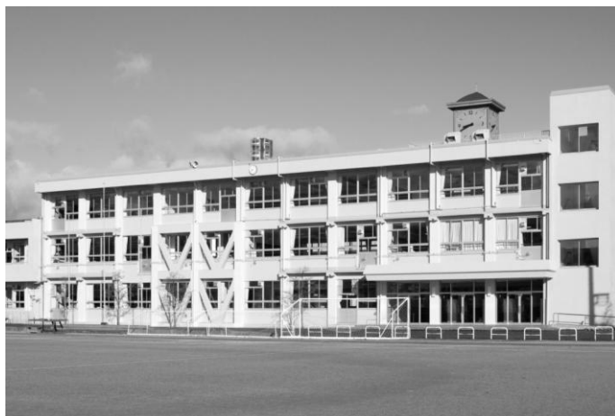
耐震工事を行った校舎
