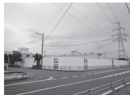
建設現場の状況(6月18日現在)
