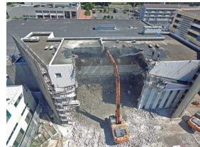
建物南側の減築
