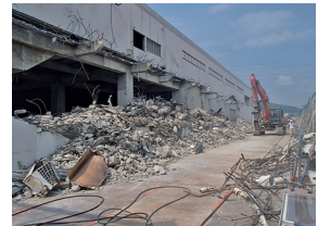
建物北側の減築
