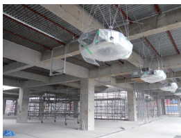
空調機器の取付
