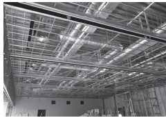
ホール棟1階天井
