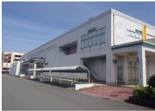
② 建物 北面
