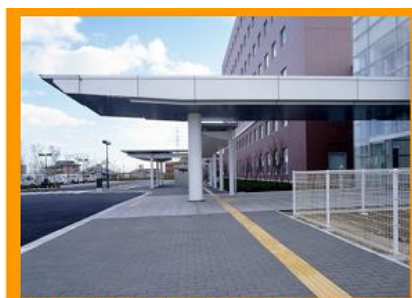
段差がなく、見通しのよいアプローチ通路 視覚障害者誘導用ブロックの敷設
