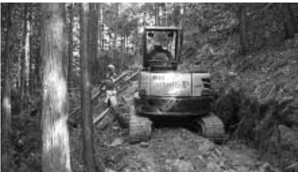
造林用作業路の開設
