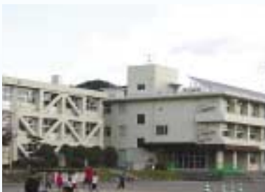
府中小(東棟)の耐震補強工事・大規模改修、太陽光発電設備設置工事を行う 太陽光発電設備の設置は町有施設“初”
