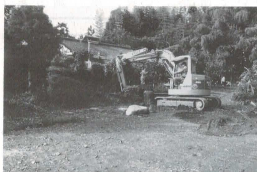
▲最初は重機によって粗掘りします。
