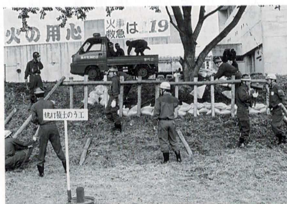
▲杭打積土のう工を行う消防団員ら
