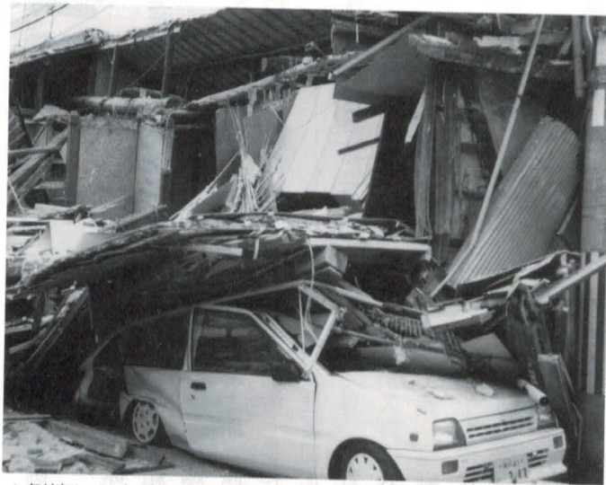
▲倒壊した家屋により押しつぶされた自動車 (写真：阪神・淡路大震災 東消防署提供)
