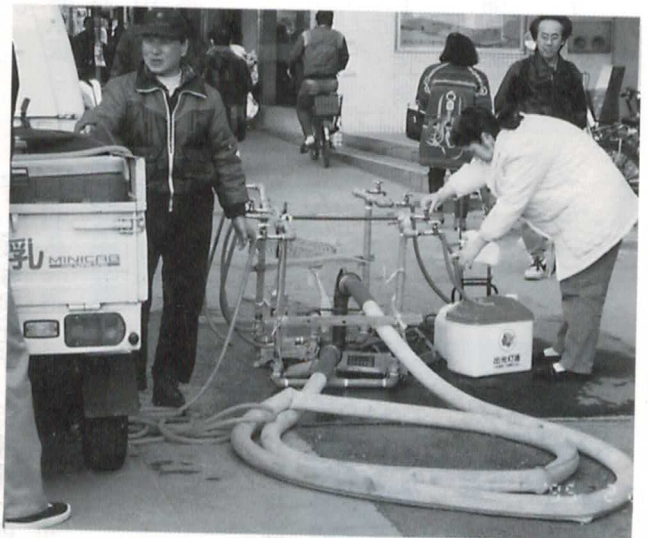
▲仮設水道から給水する被災者 (写真：阪神・淡路大震災 東消防署提供)
