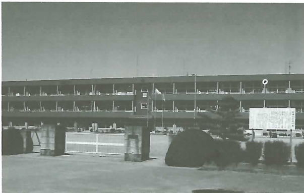
▶ 大規模改造がなされる垂井小学校校舎
