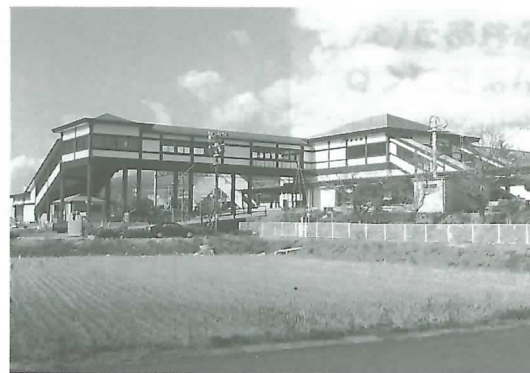
垂井町の新しい玄関口として 着々と整備が進むJR垂井駅
