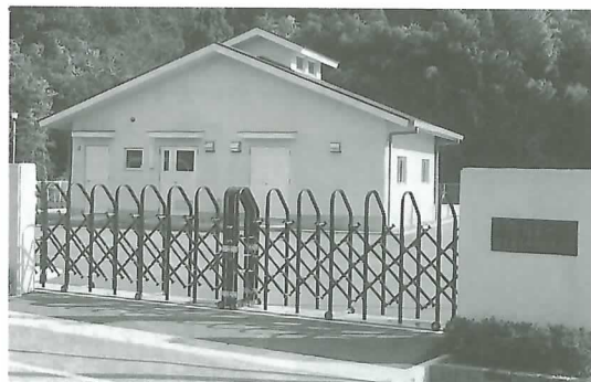
▶10月1日に使用が始まった 北部第1農業排水処理施設
