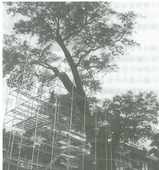
▲ 足場が組みまれいよいよ修復工事が開始
