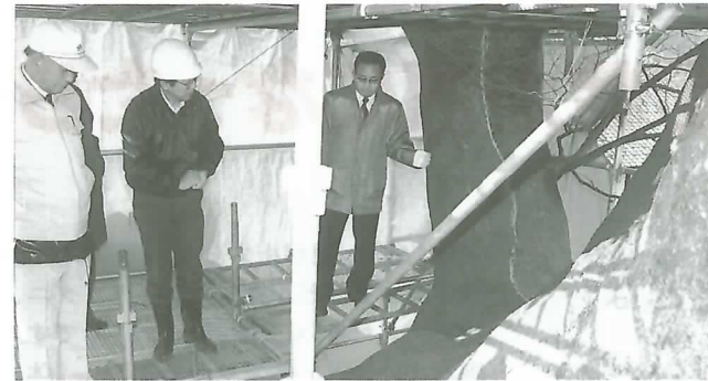
◀ 修復部分を視察する田中町長ら
