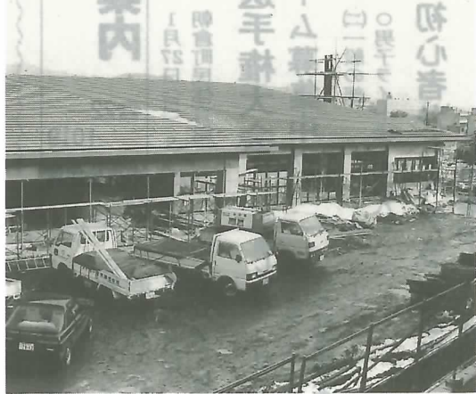
▲ 3月オープンを目指し、着々と工事が進むデイ・サービスセンター
