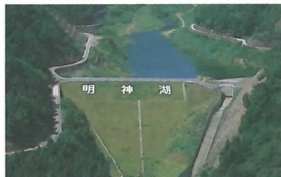
北部防災ダム
