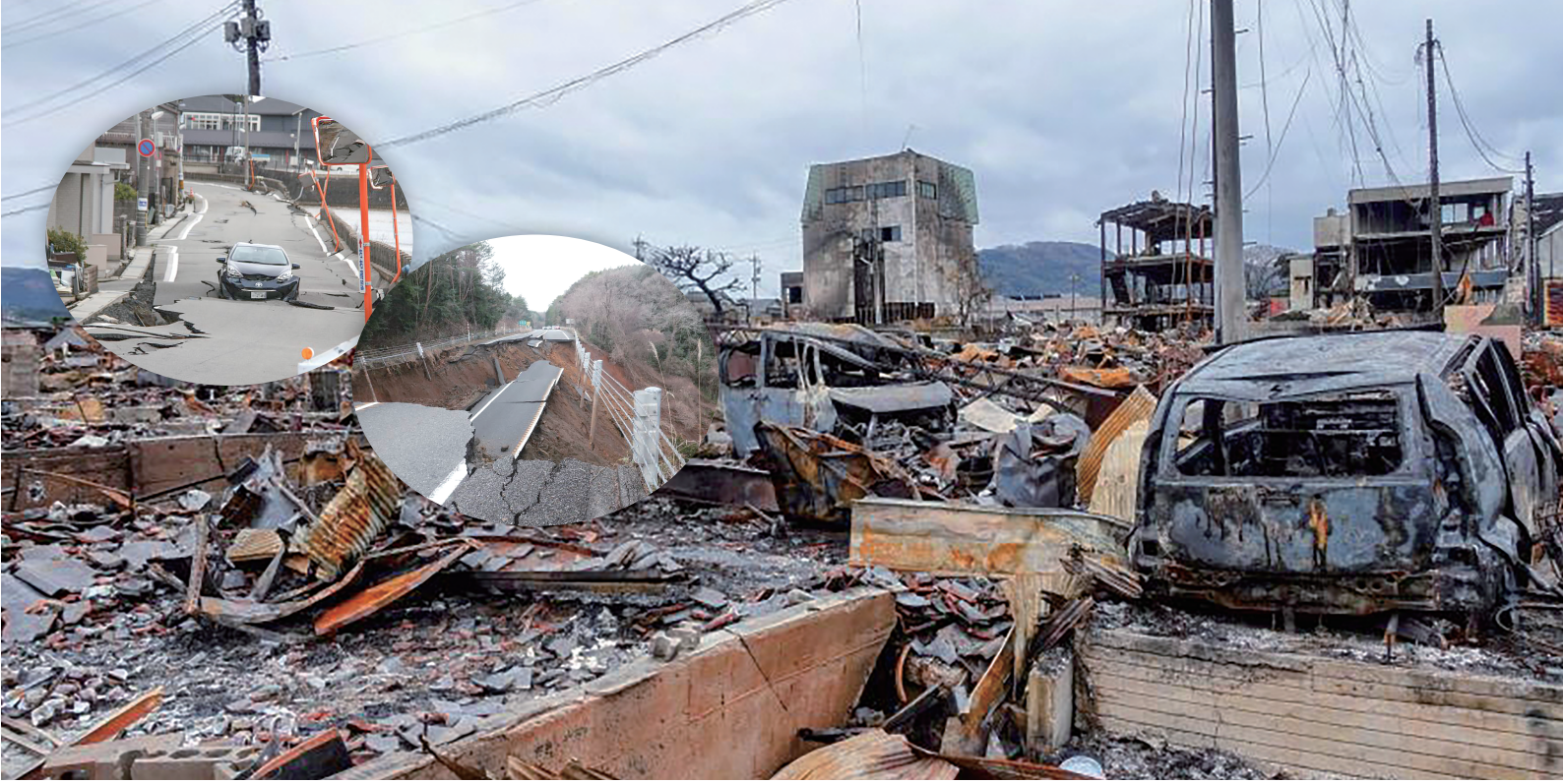
▲能登半島地震による被害の様子 石川県ホームページから引用
