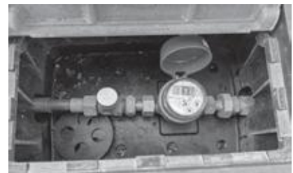
▲閉栓キャップによる給水停止
