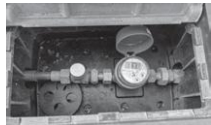
▲閉栓キャップによる給水停止
