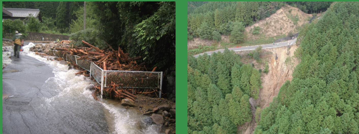
垂井町梅谷地内 平成20年 (台風被害)
