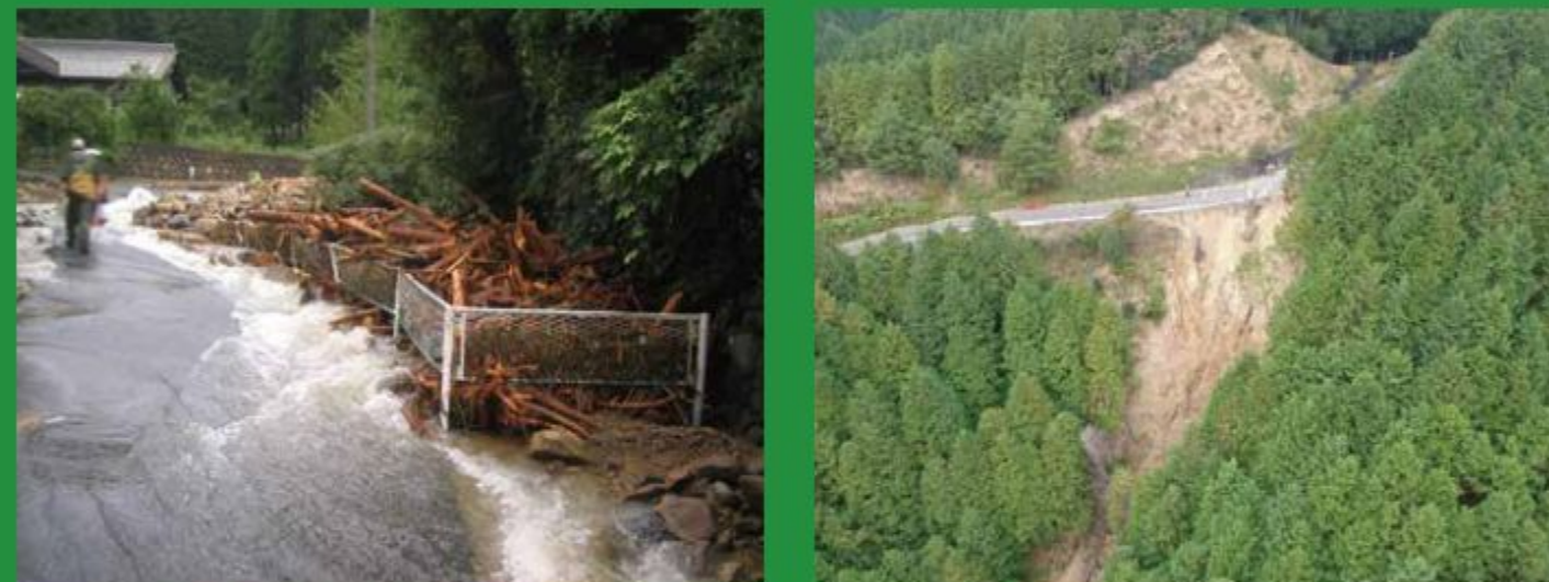
垂井町梅谷地内 平成20年 (台風被害)
