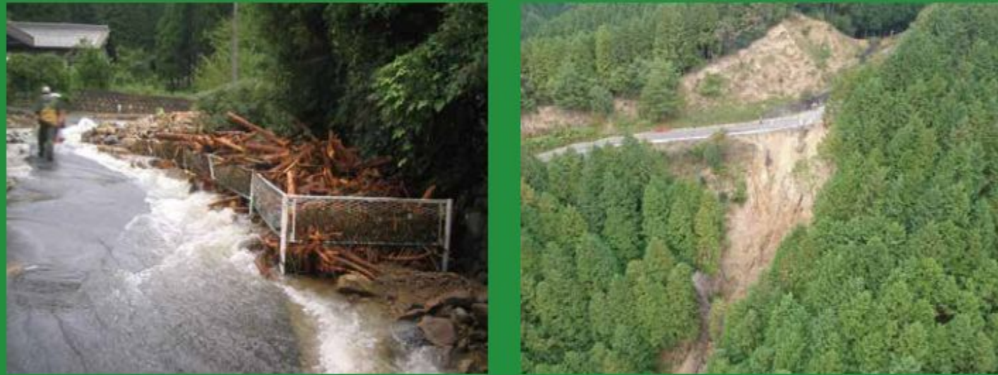
垂井町梅谷地内 平成20年 (台風被害)
