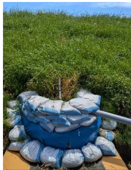
雨に設置した月の輪工法。大雨対策として、高田橋の下流の右岸(表佐側)に設置した月の輪が未だ残っています。
