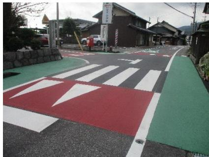
②朝晩の通行車両が多く速度も速い。家と家の間に並ぶため、集団登下校している子供の姿が見づらい。「宮代地区ゾーン30プラス」によりカラー舗装・スムーズ横断歩道を整備し完了している。
