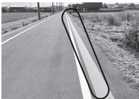
▲路肩の緑色の舗装
