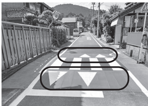
▲横断歩道手前の赤色の舗装
