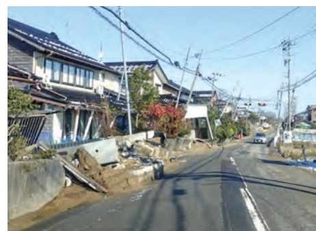
▲能登半島地震により被害を受けた町並（石川県ホームページより）
